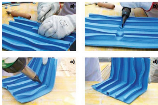
Рисунок 10.3 - 90° сварка – Idrostop PVC BE
